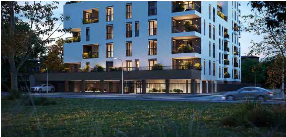
Nuovi appartamenti in piazza Tirana a Milano
