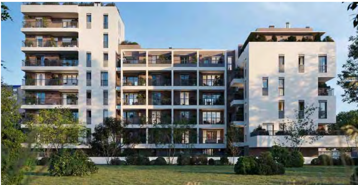
Nuovi appartamenti in piazza Tirana a Milano
